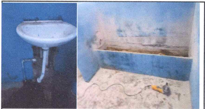
Foto 4: Retiro y Sustitución de Lavamanos
