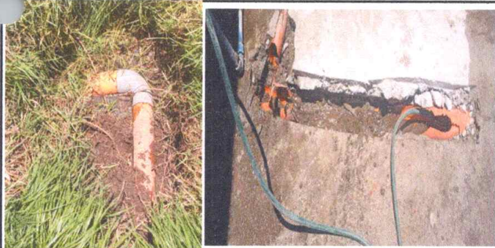
Foto 5: Perforacion y Destapado de Drenajes
