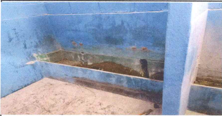
Foto 3: Destapado y reparación de mingitorios
