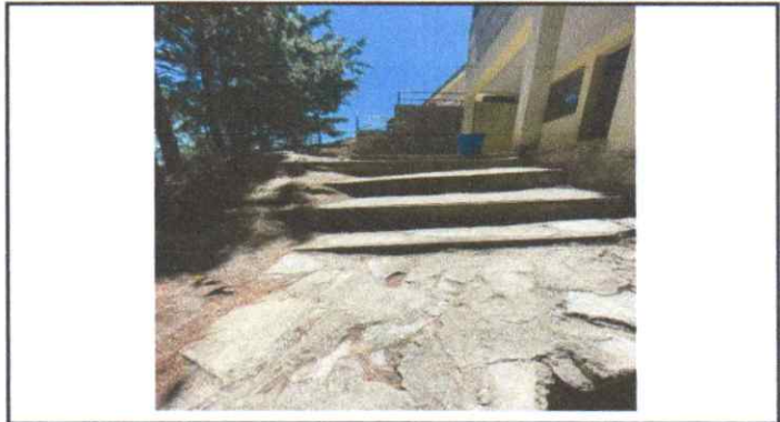
suministro de gradas para acceso a baños
