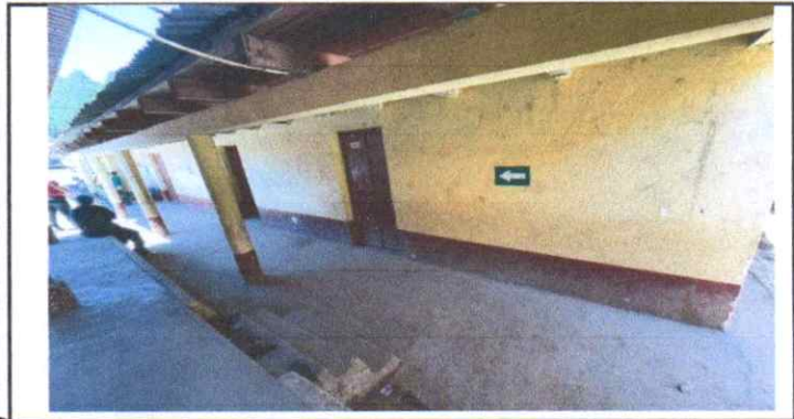
pintura en muros
