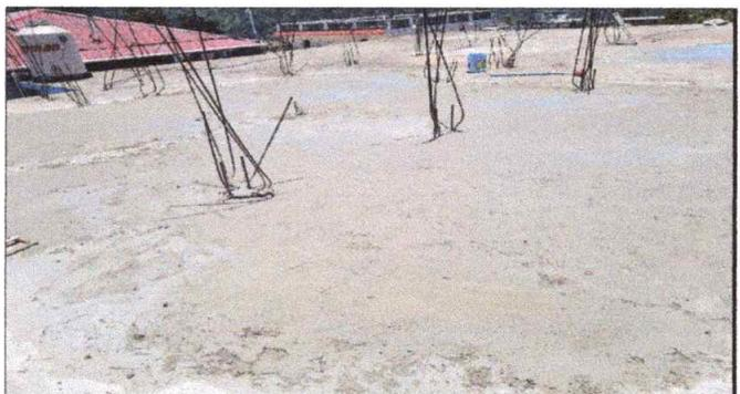
Foto 4: VISTA DE LA APLICACIÓN DE IMPERMEABILIZANTE Y SELLADOR EN LA TERRAZA FINALIZADO.
