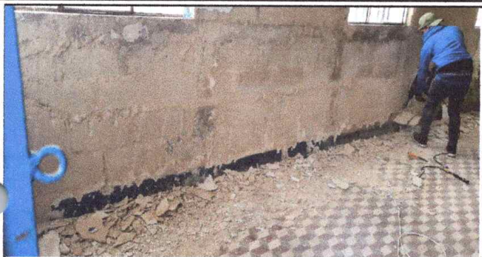
Foto 1: RETIRO DE REPELLO ANTIGUO EN PAREDES
