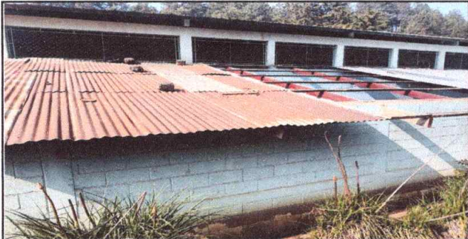
Foto 1: Cubierta de lámina
