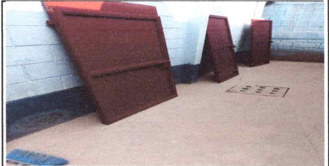
Foto 2: Mantenimiento de puertas
