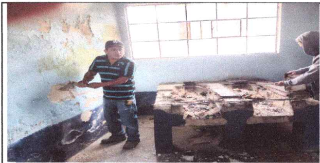
Foto 3: Planchas, pared y pintura
