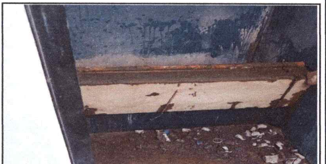
Foto 4: Mingitorio, y red de drenaje
