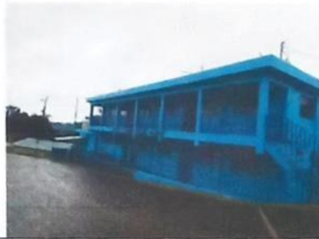
Foto 3: APLICACIÓN DE PINTURA EN MUROS EXTERIORES DEL AULA.
