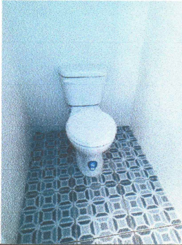
Foto1: INSTALACIÓN DE TASAS PARA BAÑOS.
