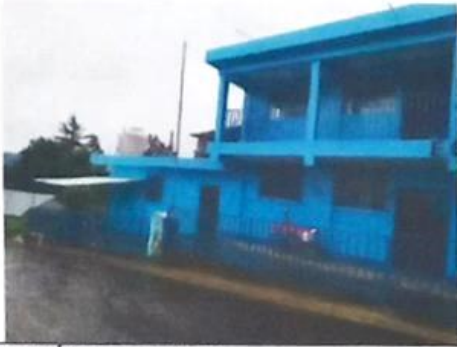
Foto1: INSTALACIÓN DE BARANDAS.
