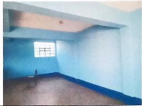
Foto 2: APLICACIÓN DE PINTURA EN MUROS INTERIORES DEL AULA.
