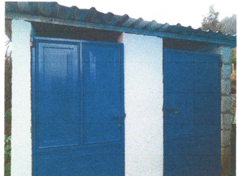
Foto 2: MANTENIMIENTO DE MUROS DE BAÑOS (REPELLO)
