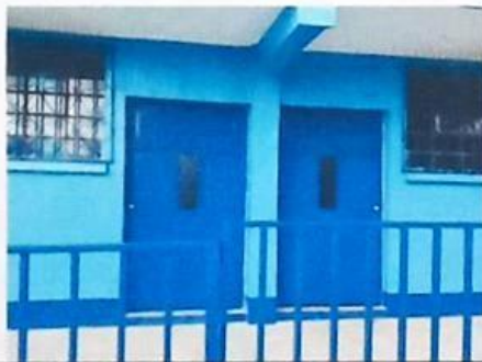
Foto 5: APLICACIÓN DE PINTURA EN PUERTAS Y BARANDAS.
