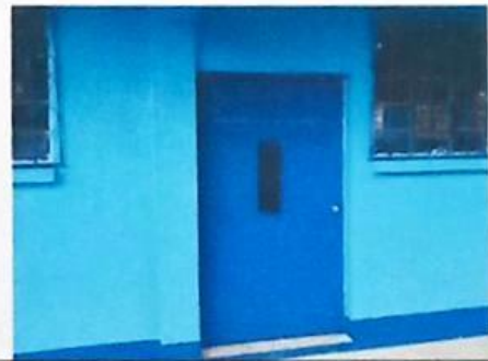
Foto 6: SUSTITUCIÓN DE PUERTAS.
