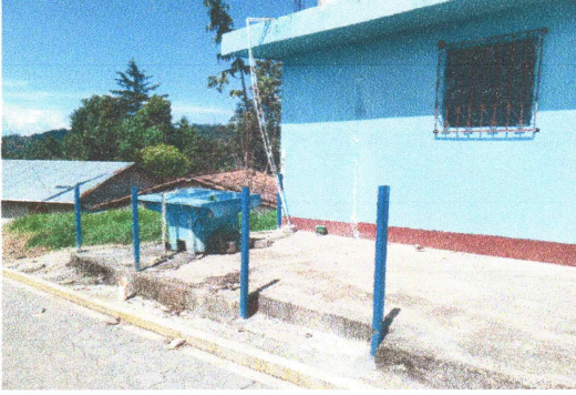
Foto1: INSTALACIÓN DE BARANDAS
