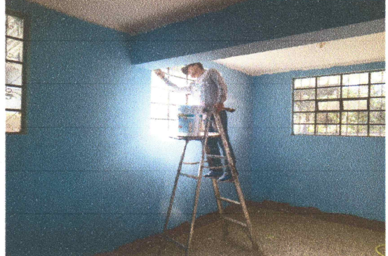
Foto 2: APLICACIÓN DE PINTURA EN MUROS INTERIORES DEL AULA.
