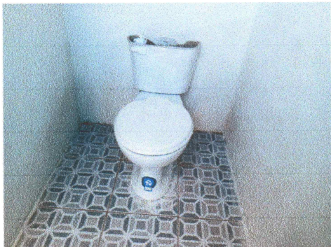
Foto1: INSTALACIÓN DE TASAS PARA BAÑOS.
