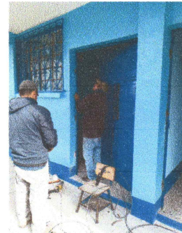
Foto 6: SUSTITUCIÓN DE PUERTA.
