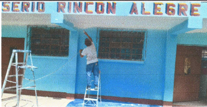
Foto 3: APLICACIÓN DE PINTURA EN MUROS EXTERIORES DEL AULA.
