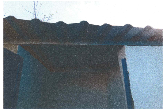
Foto 4: SUSTITUCIÓN DE LÁMINA DE TECHO PARA BAÑOS.
