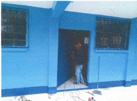
Foto 5: APLICACIÓN DE PINTURA EN PUERTAS Y BARANDAS.
