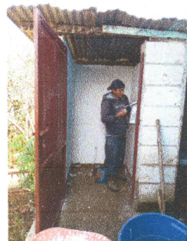
Foto 2: MANTENIMIENTO DE MUROS DE BAÑOS (REPELLO)
