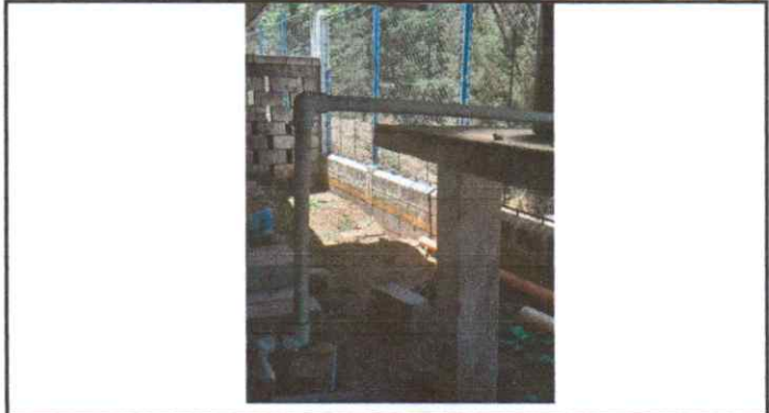
Instalación de plancha de concreto aérea para colocar rotoplas
