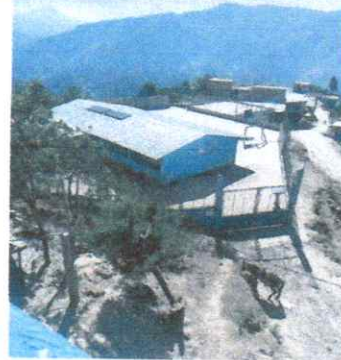
Pintura interior y exterior de la circulación de la escuela.
