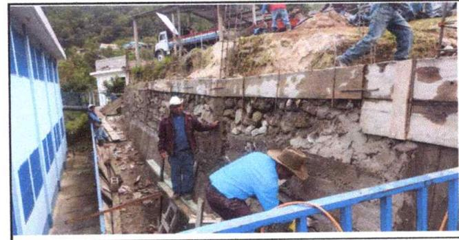
Foto 5: FUNDICIÓN DE SOLERA DE INTERMEDIO
