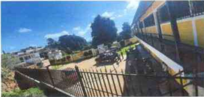
Foto 1: Completación de instalación de barandas y balcones parte de enfrente.
