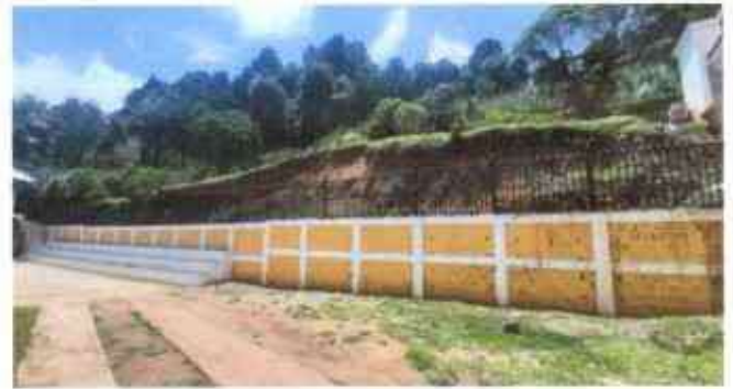
Foto 2: Finalización de barandas del muro de contención.
