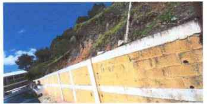
Foto 2: Limpieza de area para colocación de barandas
