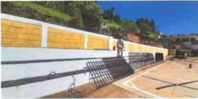
Foto 3: Colocación de barandas
