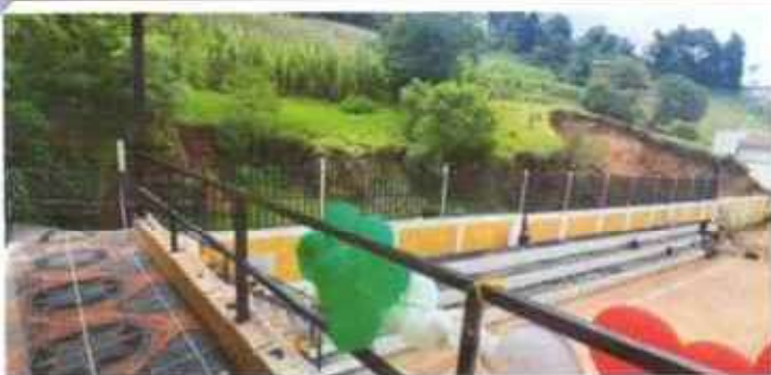
Foto 5: Seguimiento de barandas
