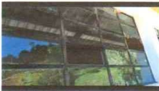
Suministro e instalación de balcones
