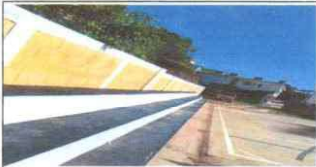
Suministro e instalación de barandas de seguridad
