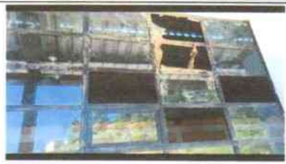
Suministro e instalación de balcones
