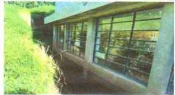
Suministro e instalación de balcones
