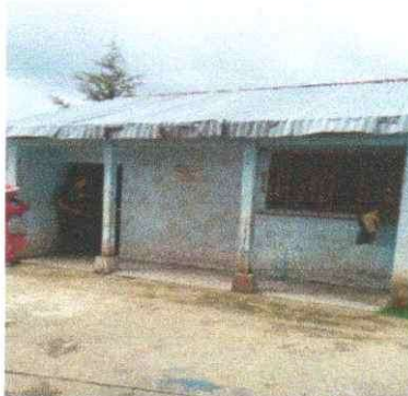
SUMINISTRO Y APLICACIÓN DE PINTURA EN PAREDES EXTERIORES E INTERIORES
