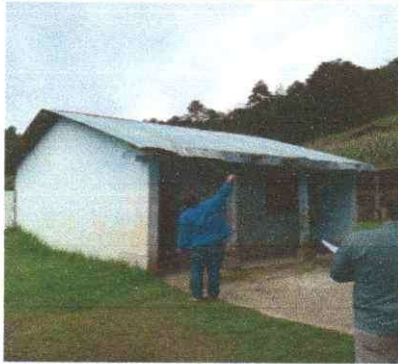
SUSTITUCIÓN DE LAMINA POR LAMINA TROQUELADA CALIBRE 26
