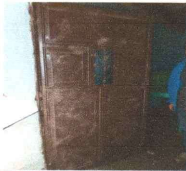
SUSTITUCIÓN DE PUERTAS DE SERVICIOS SANITARIOS
