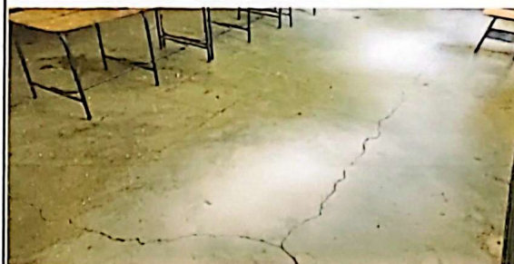
Reparación de piso de concreto.
