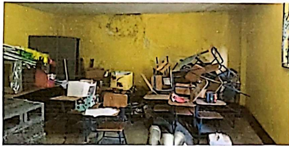
Sustitución de repello en muros.
