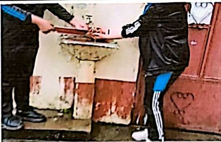
Instalación de pila de un ala.
