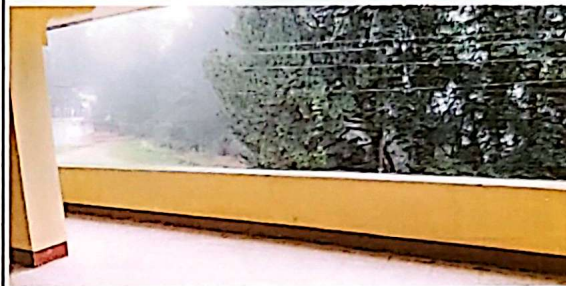
Sustitución de baranda de metal.
