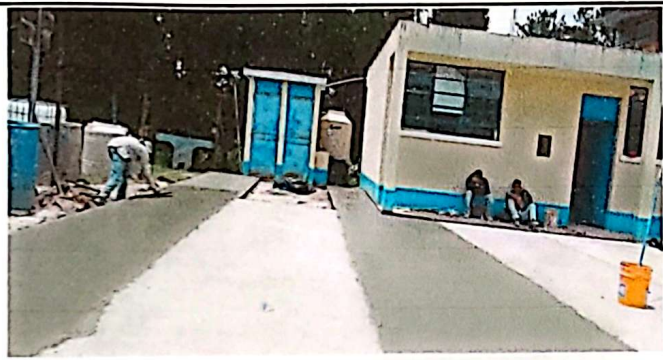
Foto 3: Sustrucción de torta de concreto en el patio.
