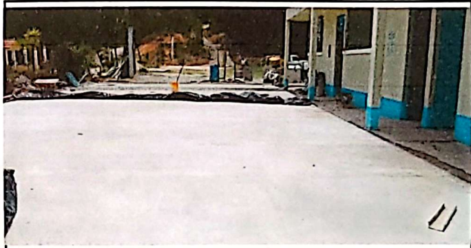
Foto 4: Sustrucción de torta de concreto en el patio.
