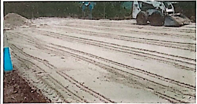
Foto 2: Sustrucción de torta de concreto en el patio.
