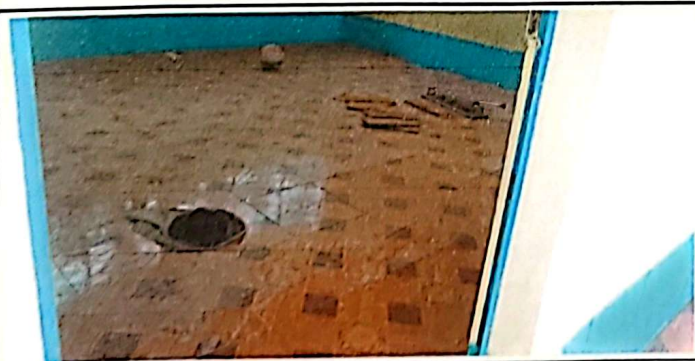
Foto 5: Sustrucción de piso de torta de concreto por piso cerámico.
