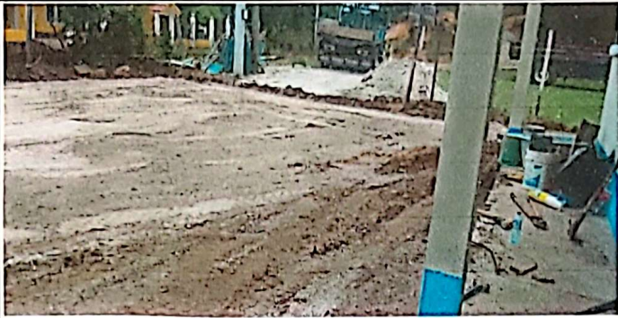
Foto1: Sustrucción de torta de concreto en el patio.
