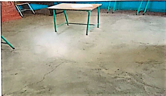
Foto 3: Sustitución de piso de torta de concreto por piso cerámico.
