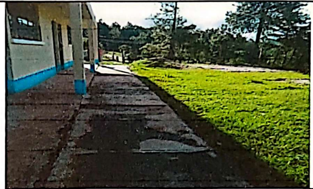
Foto 4: Sustitución de piso de torta de concreto por piso cerámico en la parte frontal del Instituto.
