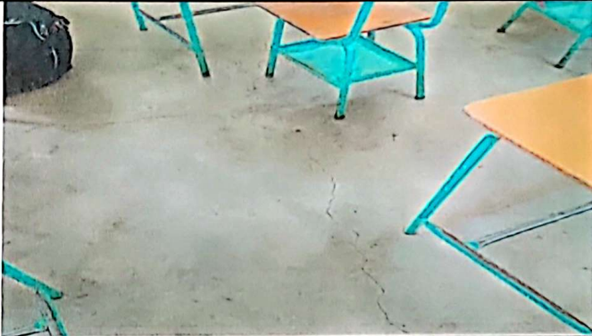
Foto1: Sustitución de piso de torta de concreto por piso cerámico.
