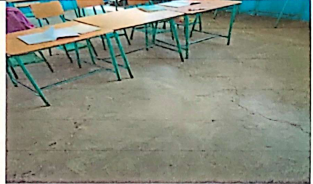
Foto 2: Sustitución de piso de torta de concreto por piso cerámico.
