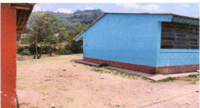
Foto 3: Lado norte del establecimiento colocación de muro perimetral, con una medida de 20 metros lineales por 2.5 metros de altura.
