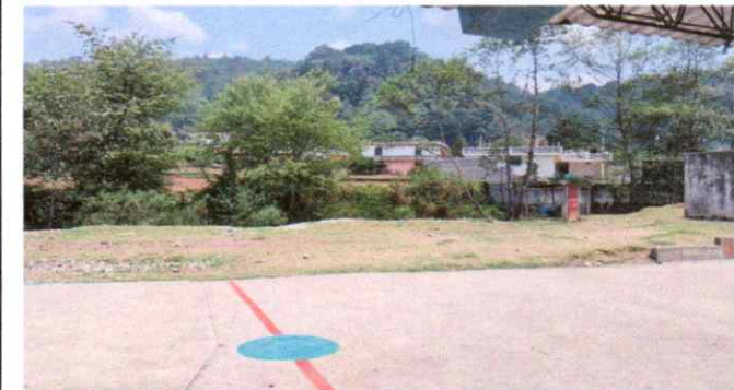
Foto 4: Lado oriente del establecimiento colocación de muro perimetral, con una medida de 42.40 metros lineales por 2.50 metros de altura.
