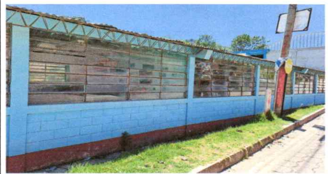
Foto 2: Instalación de balcones en 10 ventanas del lado poniente.
