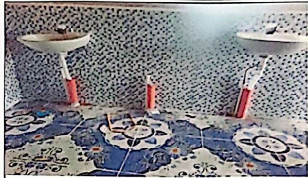
colocación de lavamanos
