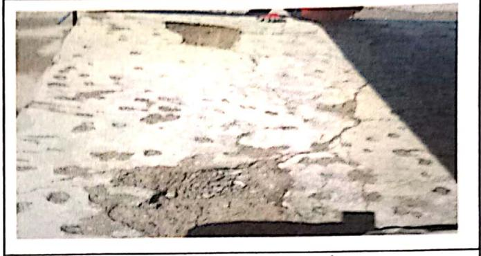
Foto 2: Sustitucion de torta de cemento por ceramica
