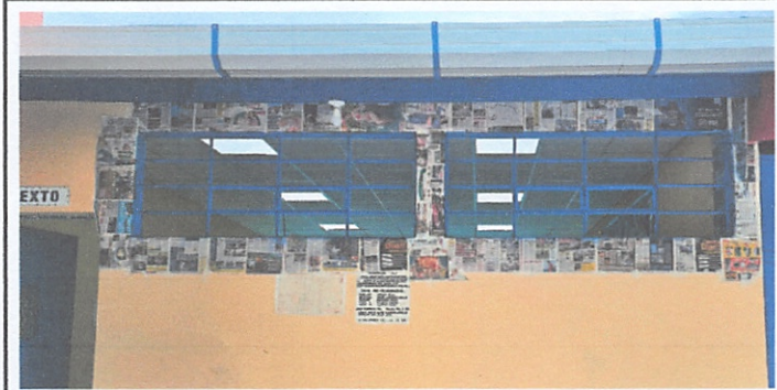
Sustitución de vidrios 5mm
