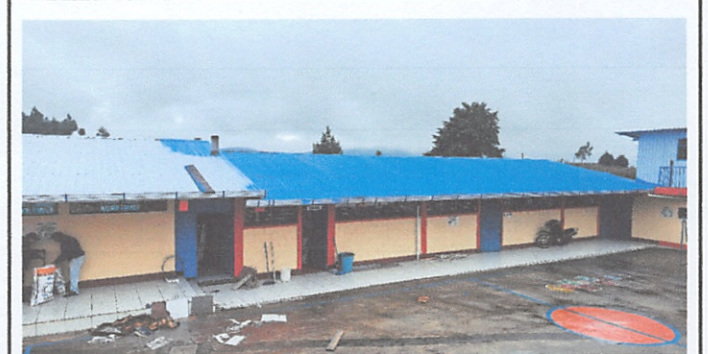
Mantenimiento de cubierta de lámina con pintura anticorrosiva
