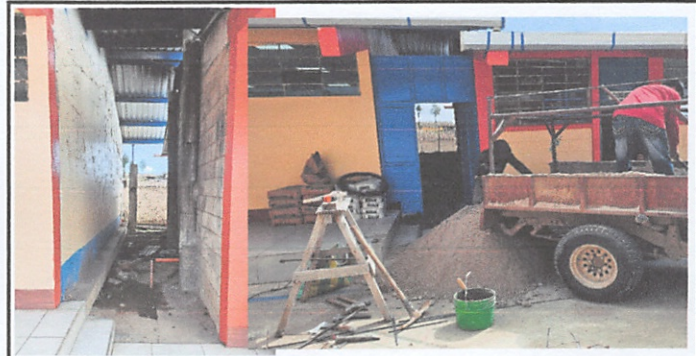
Sustitución de piso en bodega
