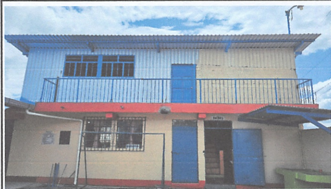
Sustitución a barandas de metal en pasillos
