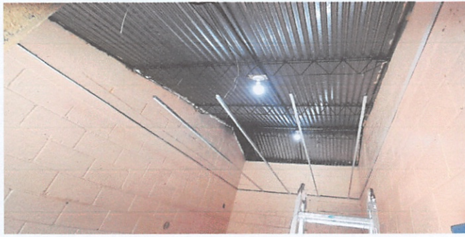
Suministro e instalación de cielo falso reticulado de fibra mineral
