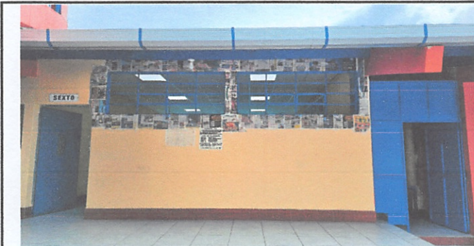
Mantenimiento a estructura de metal de ventana
