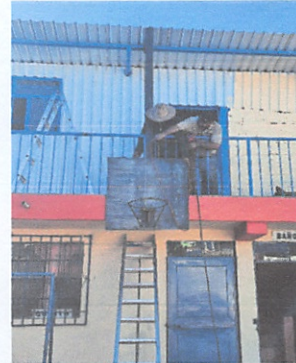
Sustitución de tableros de basquet bol
