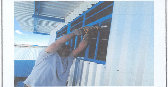
Sustitución de ventana
