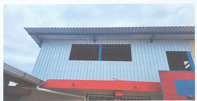
Sustitución de ventana
