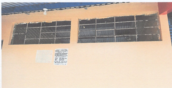
Mantenimiento a estructura de metal de ventana
