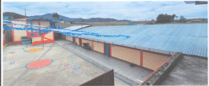
Mantenimiento de cubierta de lámina con pintura anticorrosiva
