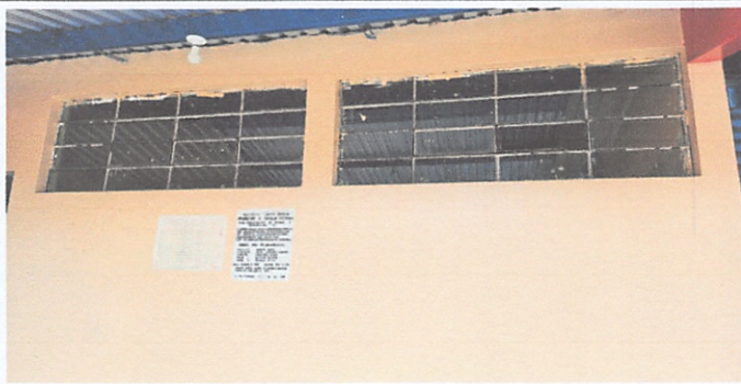
Sustitución de vidrios 5mm
