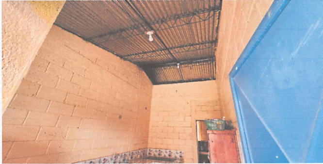
Suministro e instalación de cielo falso reticulado de fibra mineral
