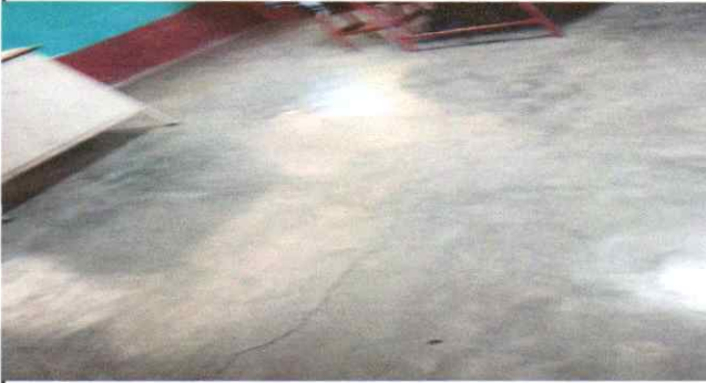
Sustitución de piso
