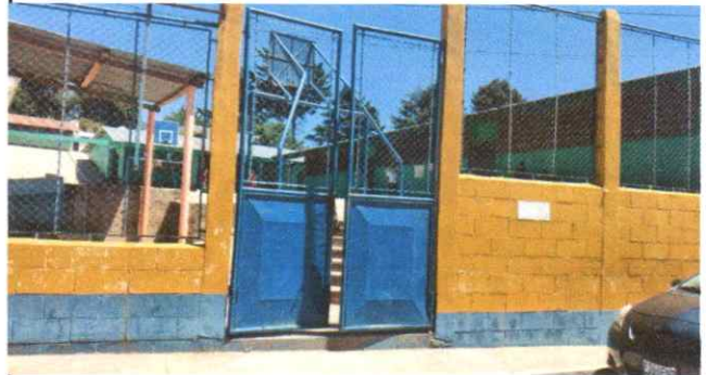
Sustitución de porton
