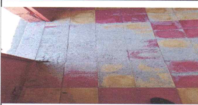
Estado actual del piso de las aulas
