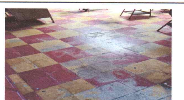
sumistro e instalacion de piso
