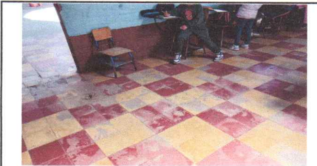
Suministro e instalación de piso
