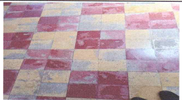
Estado actual del piso de las aulas
