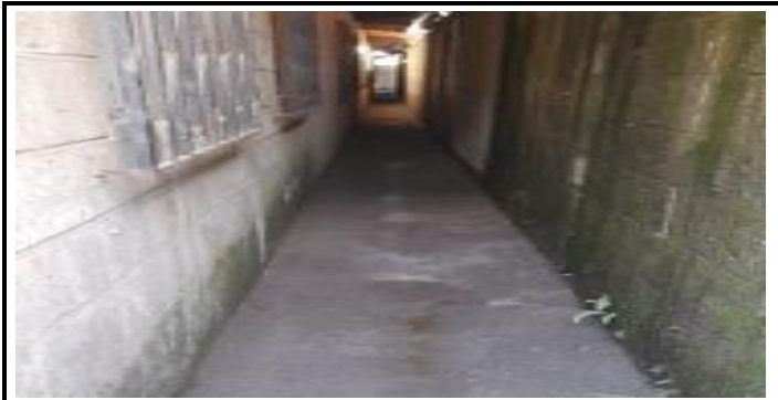
Foto 6: Sustrucción de piso de torta de concreto
