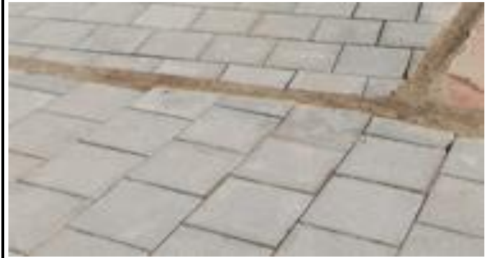
Foto 2: Sustrucción de piso con Adoquín decorativo
