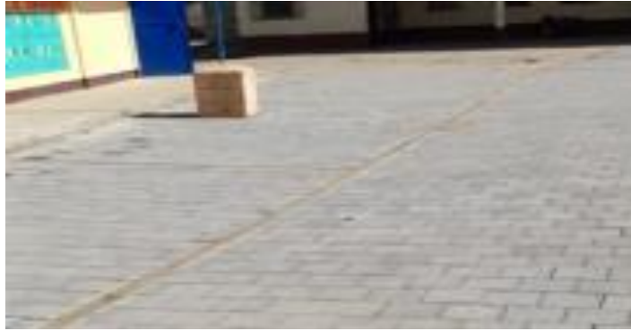
Foto 1: Sustrucción de piso con Adoquín decorativo
