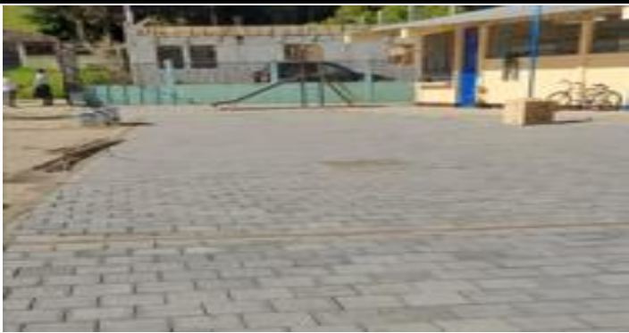
Foto 3: Sustrucción de piso con Adoquín decorativo
