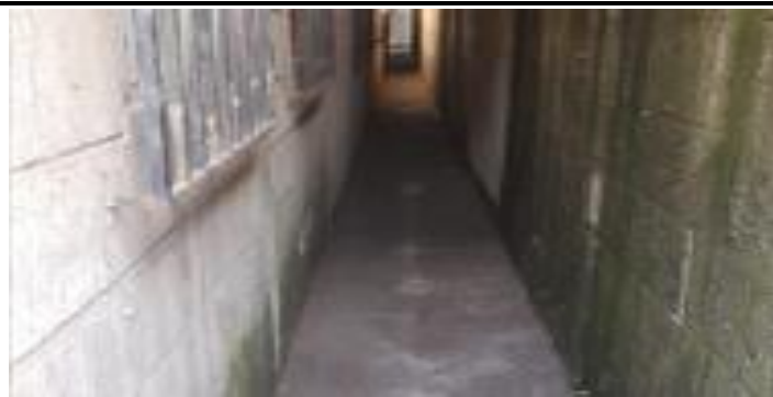
Foto 5: Sustrucción de piso de torta de concreto
