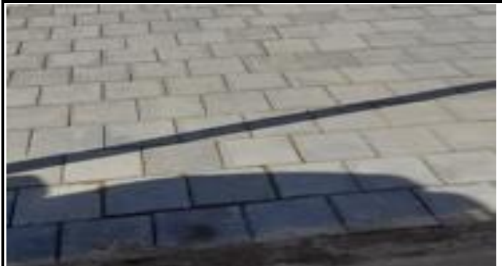
Foto 4: Sustrucción de piso con Adoquín decorativo
