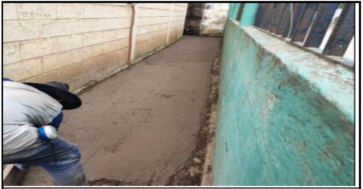
Foto 6: Sustitución de piso de torta de concreto
