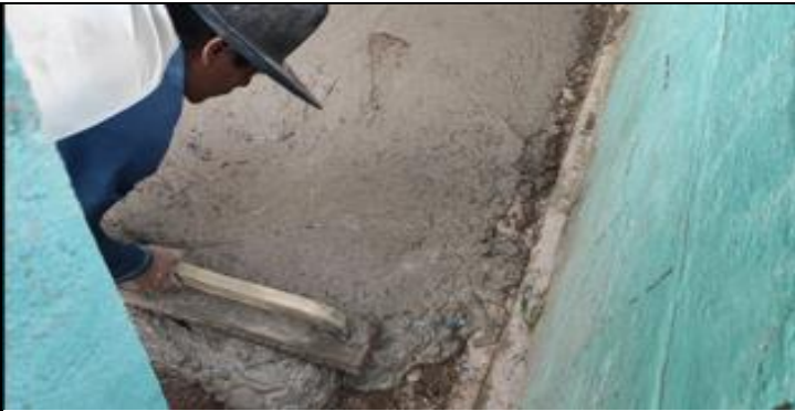
Foto 5: Sustitución de piso de torta de concreto
