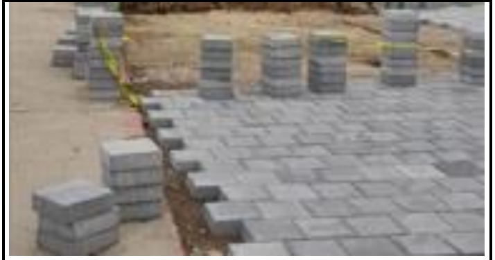
Foto 2: Sustitución de piso con Adoquín decorativo
