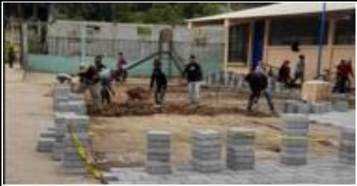
Foto 1: Sustitución de piso con Adoquín decorativo
