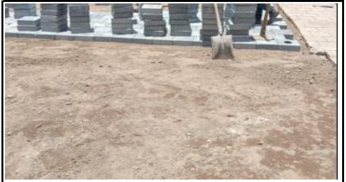
Foto 4: Sustitución de piso con Adoquín decorativo
