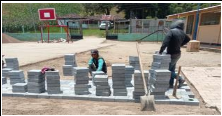
Foto 3: Sustitución de piso con Adoquín decorativo
