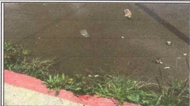
Sustitución de piso con adoquín tráfico liviano
