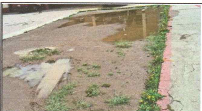
Sustitución de piso con adoquín tráfico liviano
