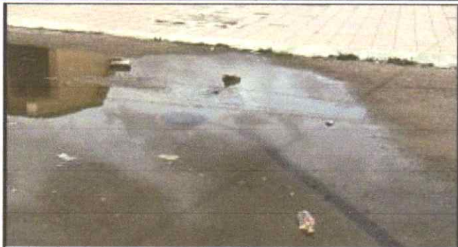
Sustitución de piso con adoquín decorativo
