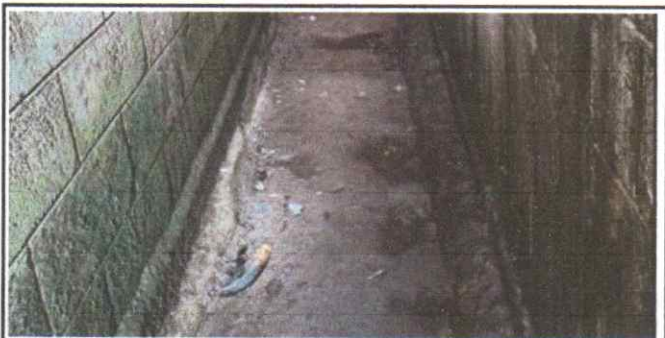
Sustitución de piso de torta de concreto
