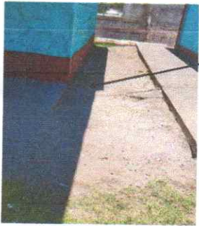
Instalacion de torta de cemento entre edificios
