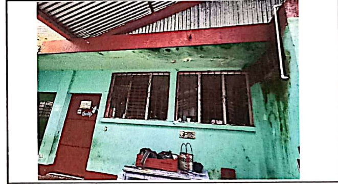
Sustitución de estructura de metal de ventana
