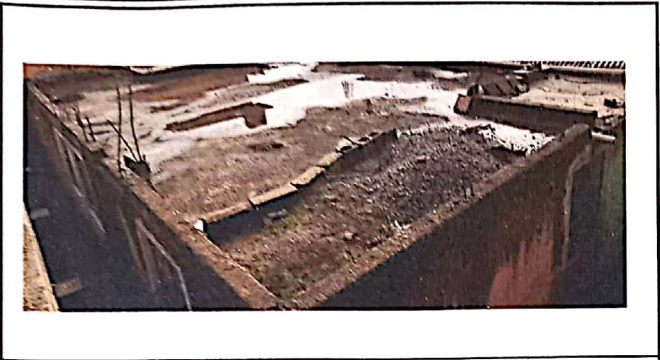
Sustitución muro de contención
