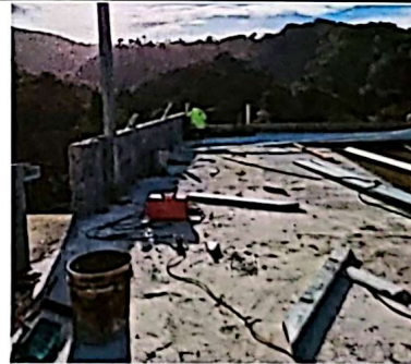
Foto 4: INICIO DE COLOCACION DE PARALES PARA EL ENTECHADO
