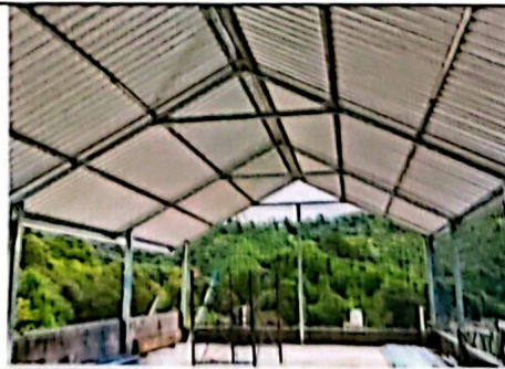
Foto 6: FINALIZA LA COLOCACIÓN DE LÁMINAS
