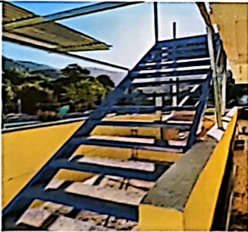
Foto 3: GRADAS PINTADAS Y LISTAS PARA SUBIR AL TERCER NIVEL
