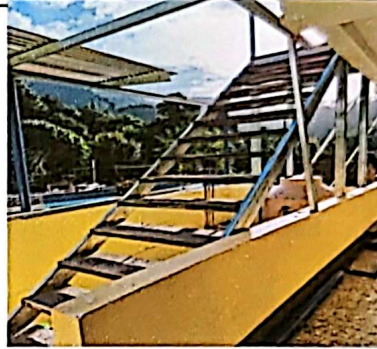
Foto 2: COLOCACION DE GRADAS PARASUBIR AL TERCER NIVEL, DONDE SE COLOCARA EL ENTECHADO
