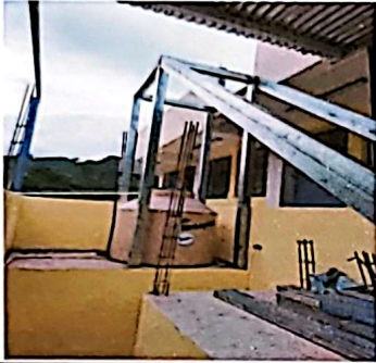
Foto 1: COLOCACION DE COSTANERAS PARA GRADAS
