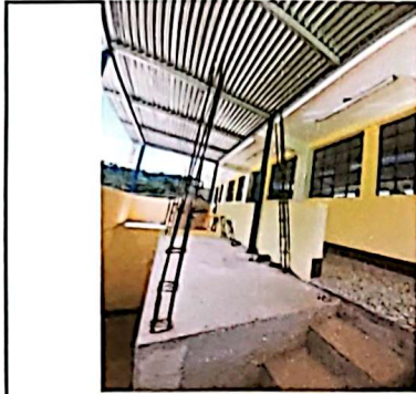
Reparación/sustitución/mantenimiento estructura portante de techo y gradas, Reparación/sustitución/mantenimiento canales y bajadas de agua pluvial
