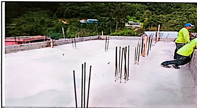
Reparación/ sustitución/ estructura portante de techo
