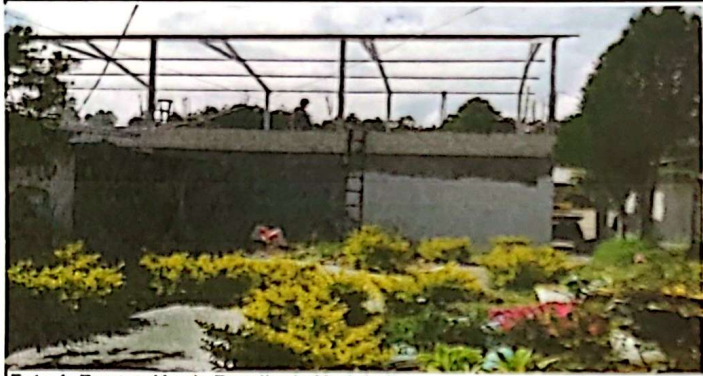
Foto 1: Reparación de Repello de Modulo II
