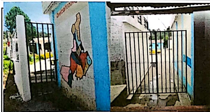
Foto 5: Mantenimiento a Portones
