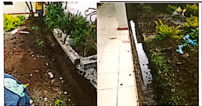
Foto 4: Cunetas de Concreto
