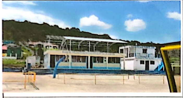
Foto 2: Sustitución de techo, de lámina troquelada calibre 26, modulo II
