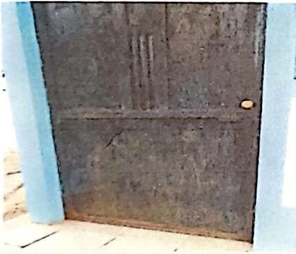
Mantenimiento a estructura (lijado, cambio de dañados, cepillado, sujeciones, aplicación de pintura anticorrosiva) en aulas, dirección y baños
