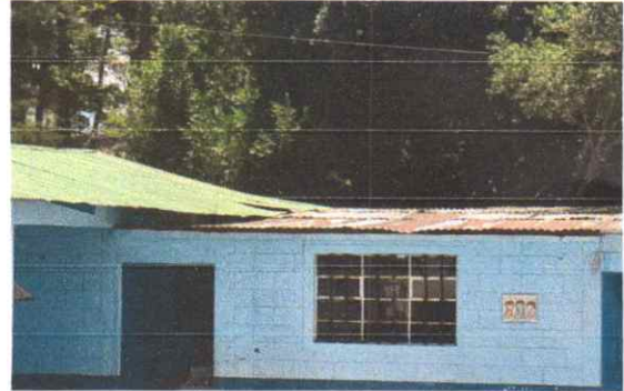
Sustitución de cubierta de lámina y sustitución de estructura portante
