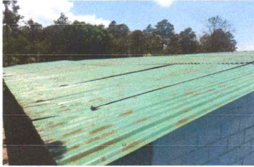
Sustitución de cubierta de lámina y sustitución de estructura portante
