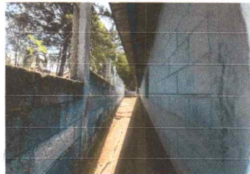
Reparación losa patio trasero
