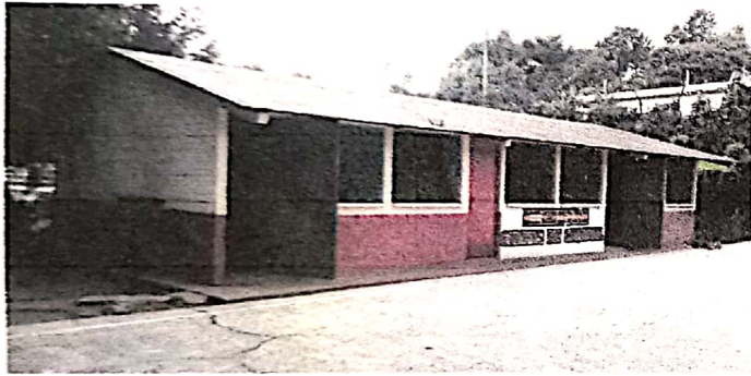
Imagen de inicio del remozamiento
