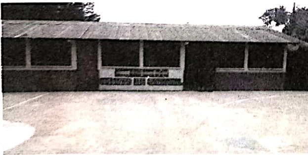
Imagen de inicio del remozamiento
