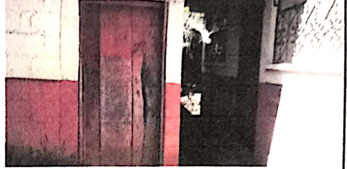
Imagen de inicio del remozamiento
