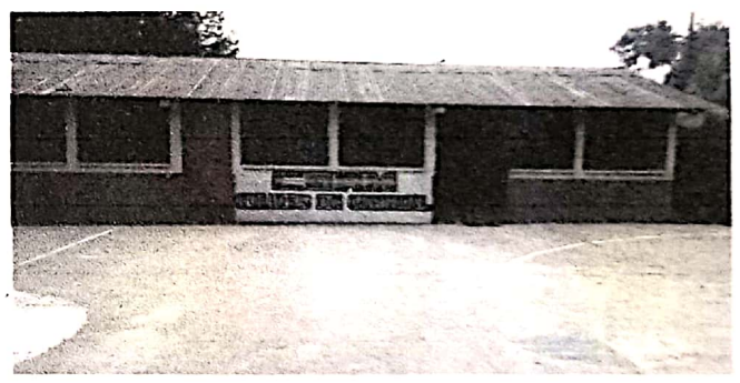
Imagen de inicio del remozamiento
