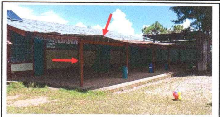
SUSTITUCION DE POSTES, CON TUBO GALVANIZADO DE 4 X 4", SUSTITUCION DE LAMINA TROQUELADA CALIBRE 26 + CAPOTE
