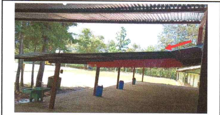
SUSTITUCION DE CERCHA TIPO PENDOLON PARA TECHO DE 2 AGUAS, CON TUBO ESTRUCTURAL GALVANIZADO DE 4 X 4"
