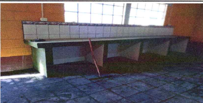
Foto 5: Reemplazo de sulo antideslizante
