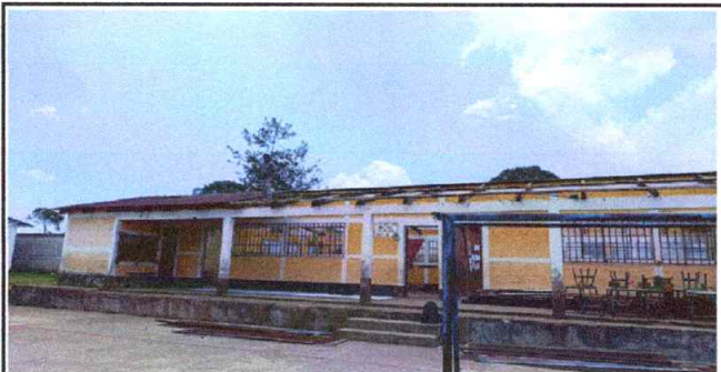
Foto 6: Reemplazo de techo laminado
