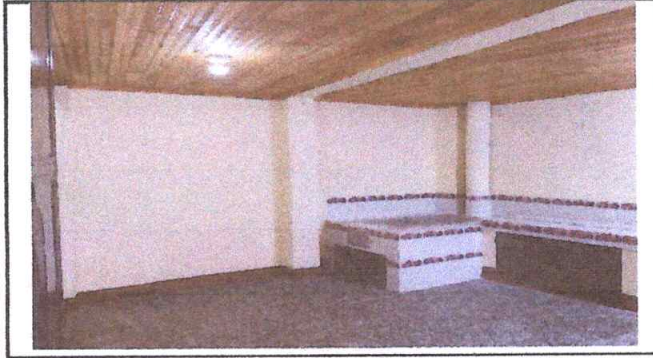
Foto 4: Describir la actividad de la fotografía: Vemos piso, techo, poyo e instalación de energía eléctrica.
