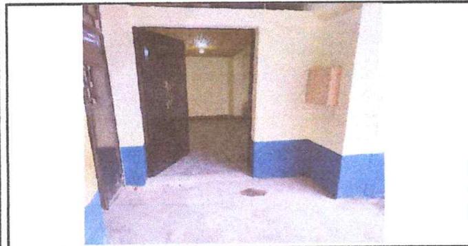
Foto 3: Describir la actividad de la fotografía: Remozamiento de pared terminada, la caja de filpones que estaba adentro se traslado hacia afuera con cubierta de madera, puertas de metal ya colocadas, pintado y piso terminado.
