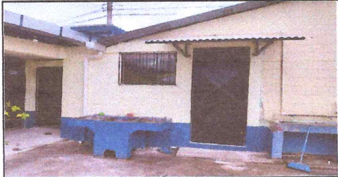
Foto 1: Describir la actividad de la fotografía: Ya remozada la pared con su ventana; ya trasladada la puerta interna a externa de la cocina de la primaria, la pila corrida a la izquierda, y a la izquierda ya la puerta de entrada a la cocina terminada.
