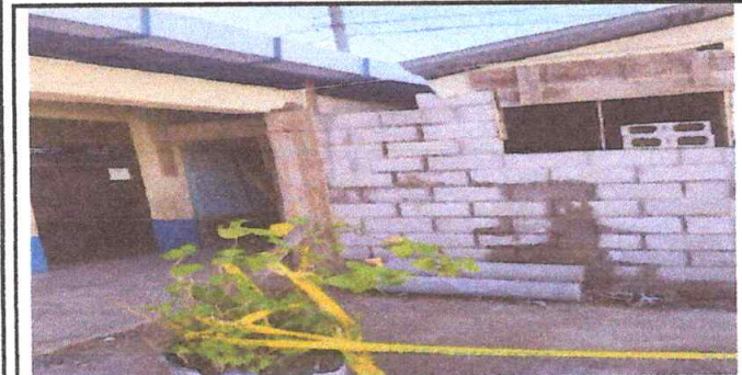
Foto 5: Describir la actividad de la fotografía: Ya remozada la pared para cubrir la cocina.
