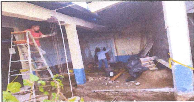
Foto 1: Describir la actividad de la fotografía: Remozando cimientos y drenajes de la cocina.
