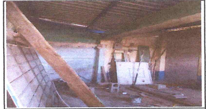
Foto 4: Describir la actividad de la fotografía: Despejada el área donde se remozara la cocina.
