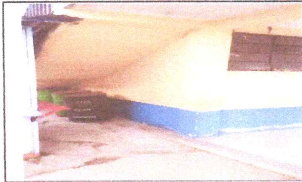
Sustitución de muro en bodega y cocina
