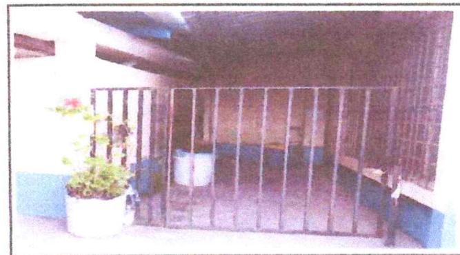
Suministro e instalación de ventana de estructura de metal
