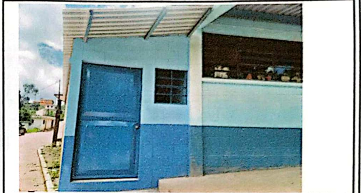
Foto 2: Entechado del almacen y colocación de puerta terminada al 100%.
