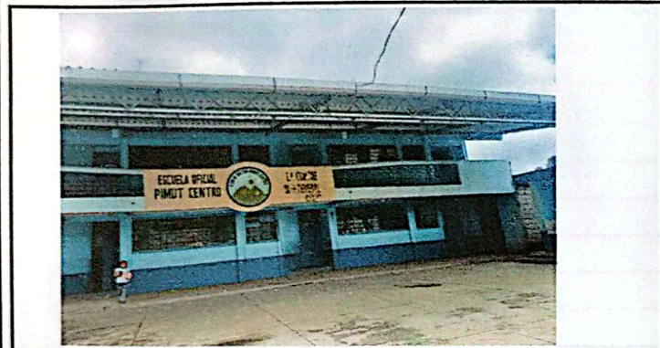
Foto 3: Remodelación de entechado del patio con lamina troquelada terminada al 100%.
