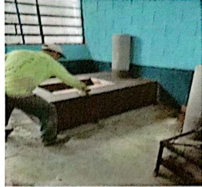
Foto 2: Reparación de la plancha de metal y concreto.
