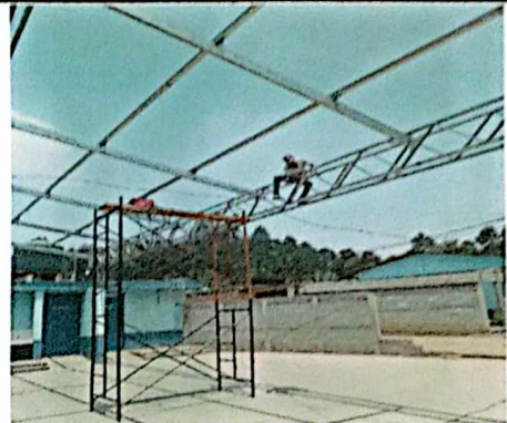
Foto 4: Remodelación, entechado del patio con lamina troquelada.
