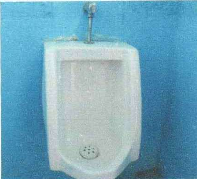
Foto 3: SUSTITUCION DE MINGITORIO
