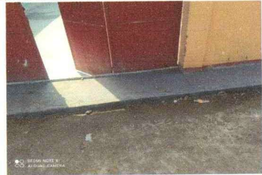
Foto 6: SUSTITUCION DE BANQUETA PERIMETRAL
