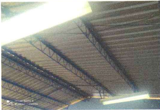
Foto 5: SUSTITUCION DE TUBOS FLUORESCENTES A LED
