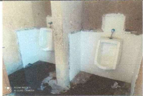
Foto 6: SUSTITUCION DE MINGITORIOS
