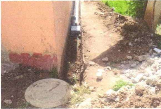
Foto 1: MANTENIMIENTO DE SISTEMA DE DRENAJE SANITARIO
