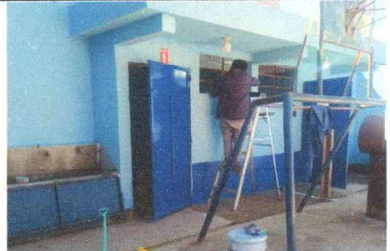
Foto 4: SUSTITUCION DE PLAFONERAS Y LAMPARAS
