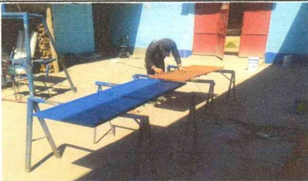
Foto 3: MANTENIMIENTO DE PUERTAS METALICAS
