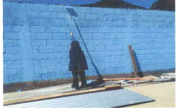
Foto 2: PINTADO DE MUROS EXTERIORES
