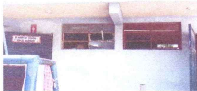
SUTITUCION DE VIDRIO DE 5mm, SUSTITUCION DE PLAFONERAS CON BOMBILLO LED DE ALTA POTENCIA 40W
