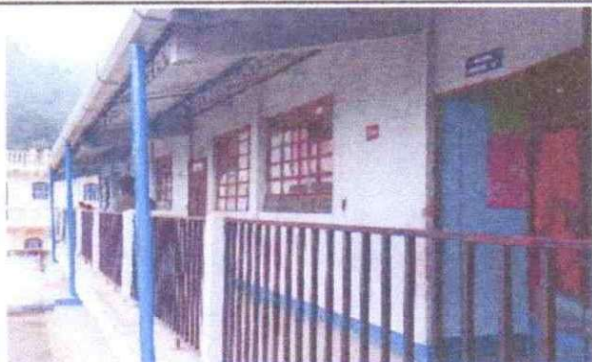
MANTENIMIENTO DE BALCONES EXISTENTE
