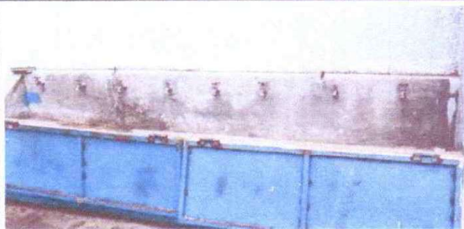
REPARACION DE LAVAMANOS EXTERIORES
