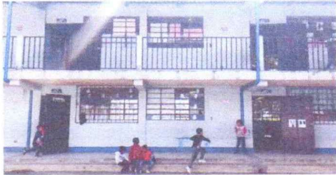
SUMINISTRO Y APLICACIÓN DE PINTURA ESMALTE ALQUIDICO EN MUROS
