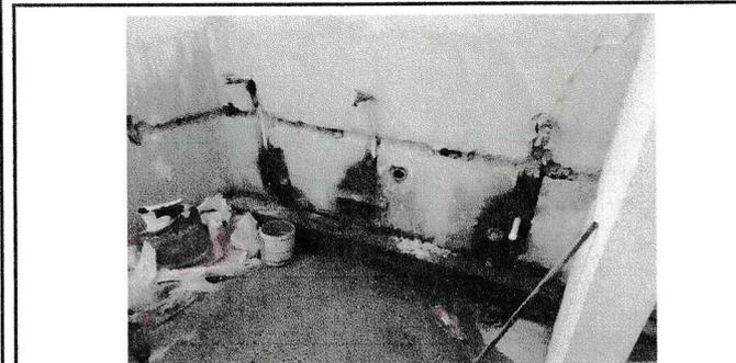
5.- FUNDICION DE BASE DE CONCRETO PARA LAVAMANOS (incluye demolicion de existente)
