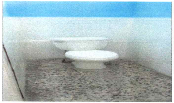
Sustitución de inodoros
