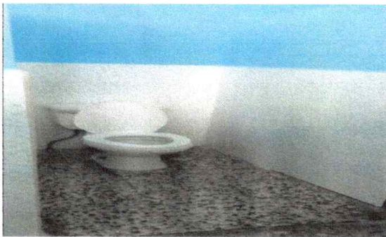
Sustitución de inodoros
