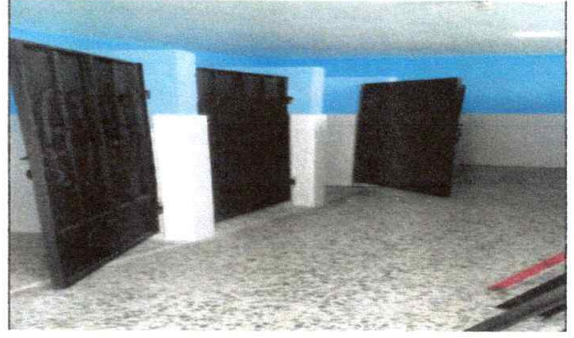
Mantenimiento a estructuras de puertas
