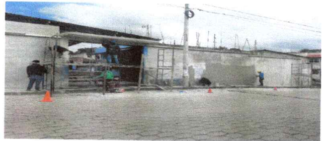
Mantenimiento de muro perimetral
