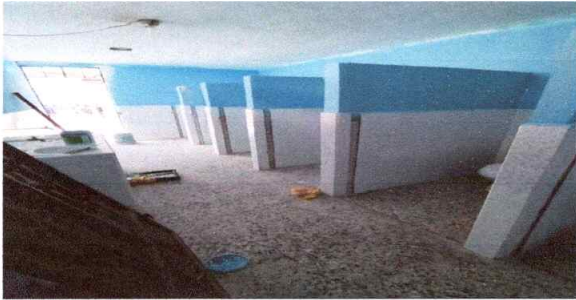
Sustitución de inodoros
