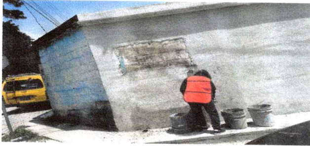
Mantenimiento de muro perimetral
