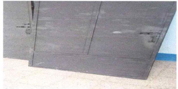
Mantenimiento a estructura de puertas
