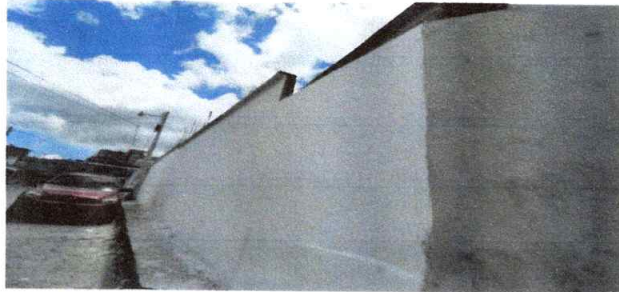
Mantenimiento de muro perimetral
