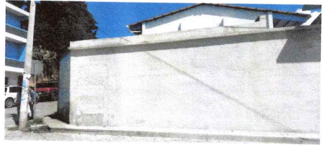
Mantenimiento de muro perimetral
