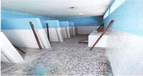
Sustitución de inodoros
