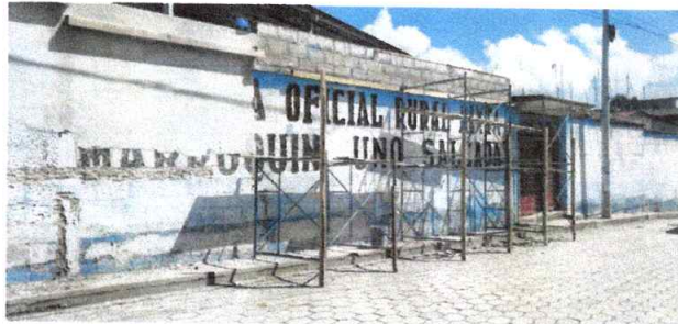
Mantenimiento de muro perimetral
