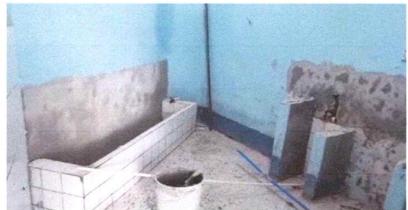
Sustitución de lavamanos con grifería
