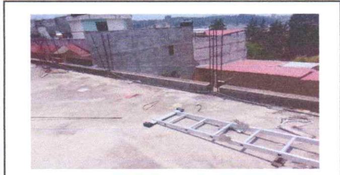
Suministro e instalación de malla perimetral
