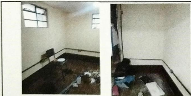
Foto 5 : REPELLO + CERNIDO, PISO CERAMICO, PINTURA Y REACONDICIONAMIENTO DE SISTEMA ELECTRICO (DIRECCION) AL 100%
