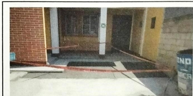
Foto 6: FUNDICION DE PAVIMENTO PEATONAL (COORDINACION MUNICIPAL DE EDUCACION) AL 100%
