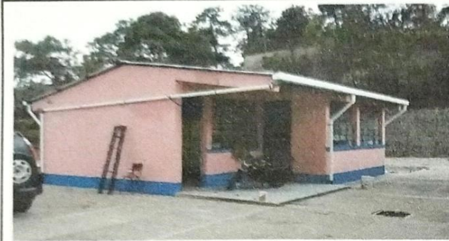
Foto1: VISTA POSTERIOR DE MODULO DE SOLDADURA, CON CUBIERTA, CANALES PLUVIALES, PINTURA Y SISTEMA ELECTRICO, TRABAJO AL 100%
