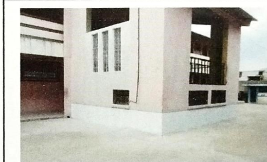
Foto 4: MURO DE MAMPOSTERIA + BLOCK DE VIDRIO EN MODULO DE GRADAS, TRABAJOS DE IMPERMEABILIZACION SOBRE Y BAJO DE NIVEL DE PISO TERMINADO (DIRECCION) AL 100%
