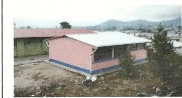
Foto2: VISTA POSTERIOR DE MODULO DE SOLDADURA, CON CUBIERTA, CANALES PLUVIALES, PINTURA Y SISTEMA ELECTRICO, TRABAJO AL 100%
