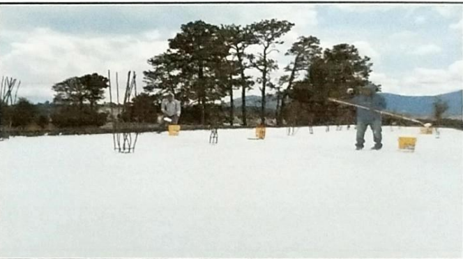
Foto 4: Aplicación de impermeabilizante
