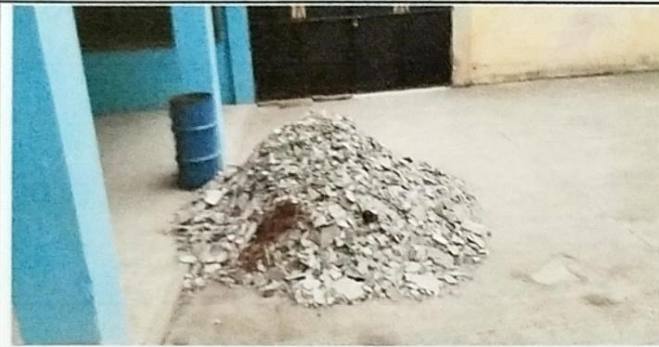
Foto 3: Material de desperdicio retirada del área de losa
