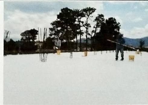
Foto 6: Colocación de Inpermiabilizante
